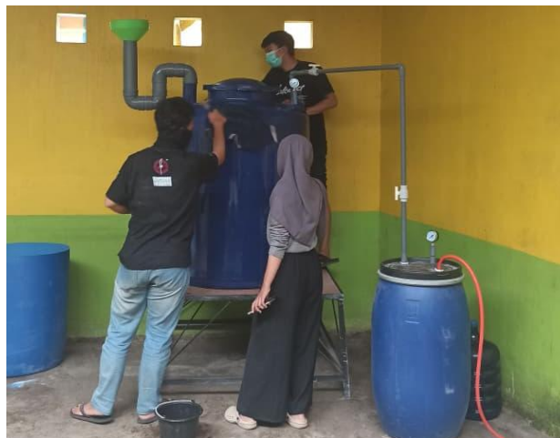
Gambar 7. Proses Instalasi Alat Sumber: Dokumentasi Pengabdian (2025)
